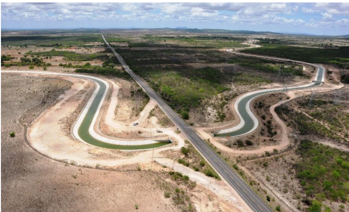
Figura 4-8 Cruzamento do canal com a rodovia
