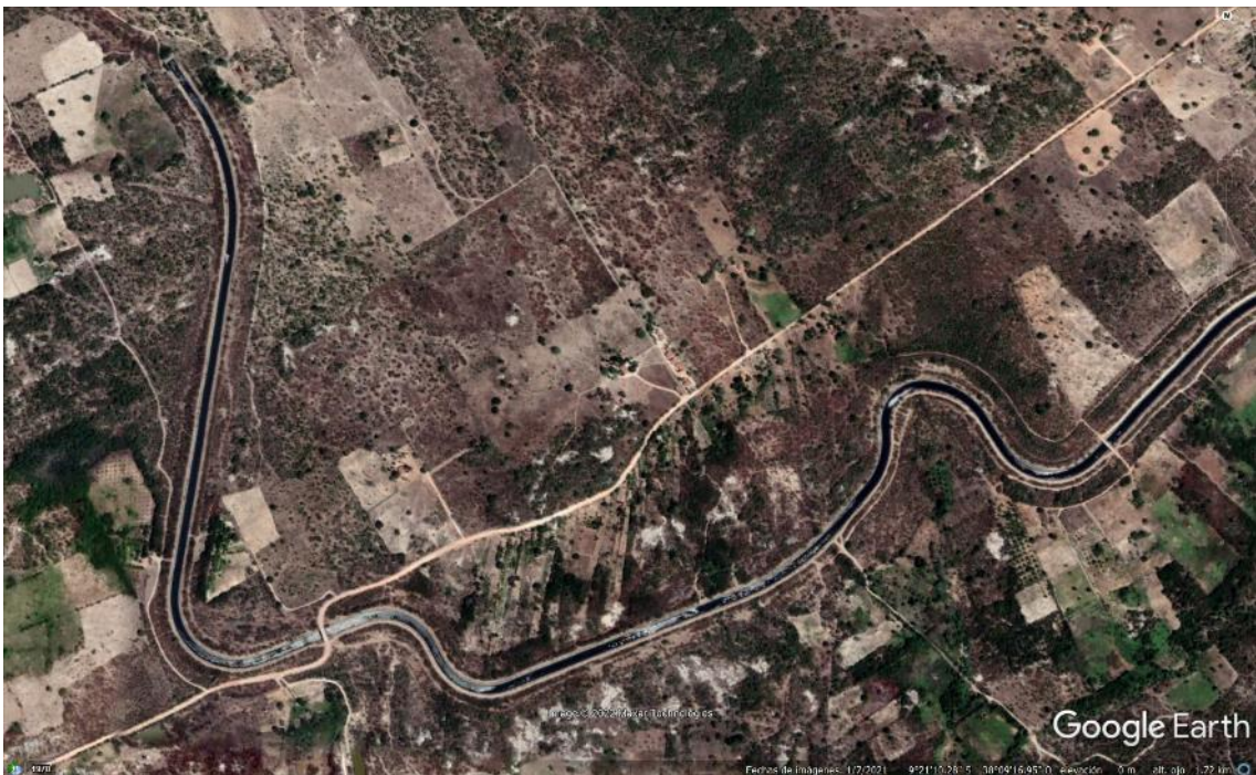
Figura 4-4 Vista satelital tramo existente canal
