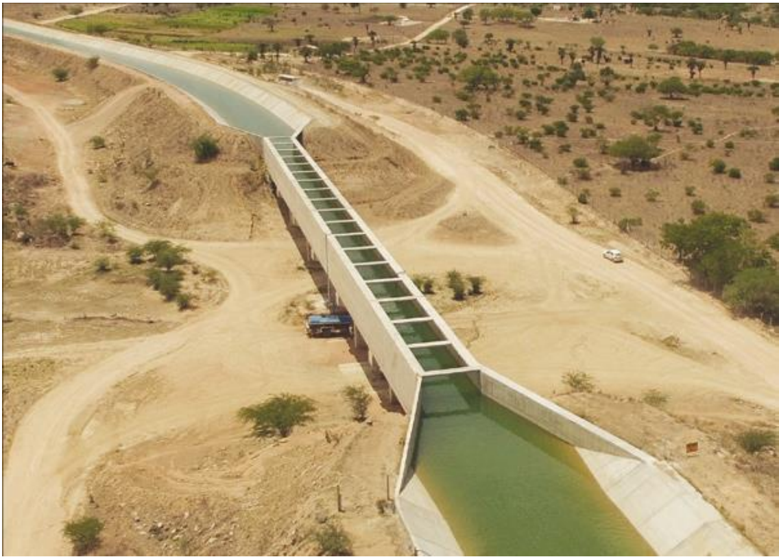
Figura 4-7 Aqueduto do canal
