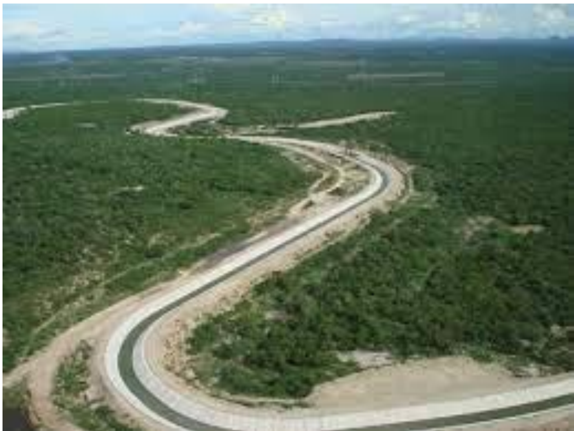
Figura 4-6 Vista tramo canal existente
