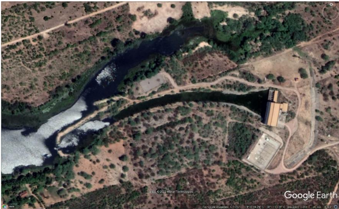
Figura 4-3 Obra de tomada represamento Moxoto ao Canal Sertão Alagoano
