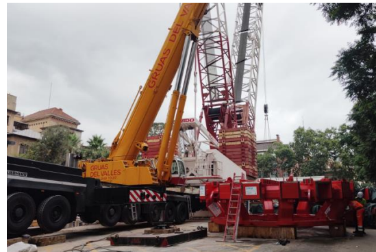
Tuneladora S-442. Cambio rueda de corte en Zona Universitària
