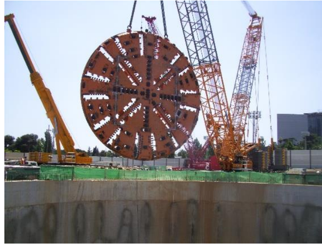
Tuneladora S-442. Cambio rueda de corte en Zona Universitària
