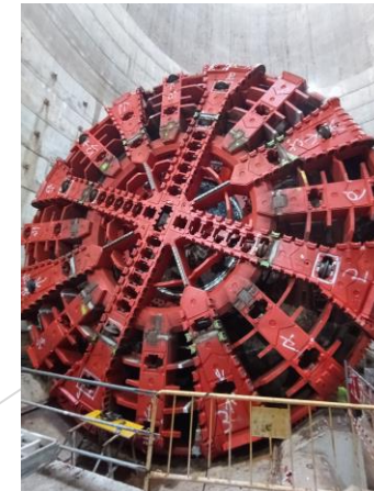
Tuneladora S-442. Cambio rueda de corte en Zona Universitària
