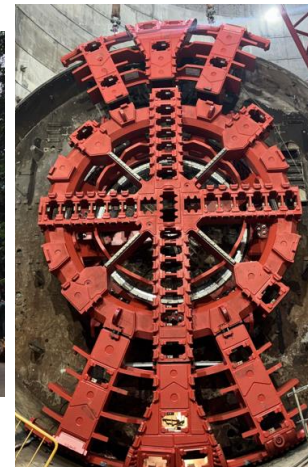
Tuneladora S-442. Cambio rueda de corte en Zona Universitària
