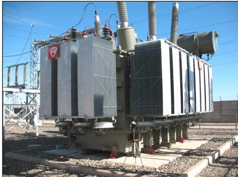
**Figura 15:** Transformador EFACEC – PORTUGAL 220/23 KV, 75 MVA. S/E Choapa, Los Vilos.
