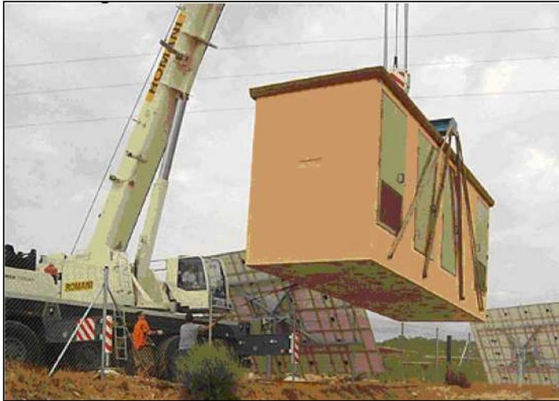
**Figura 13:** Grúa motorizada para el montaje de elementos.
