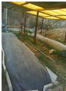
Sistema integrado de generación de energía y fertilizante, y reutilización de aguas residuales en el Zoológico Municipal "Vesty Pakos" a partir de la instalación de biodigestores.
