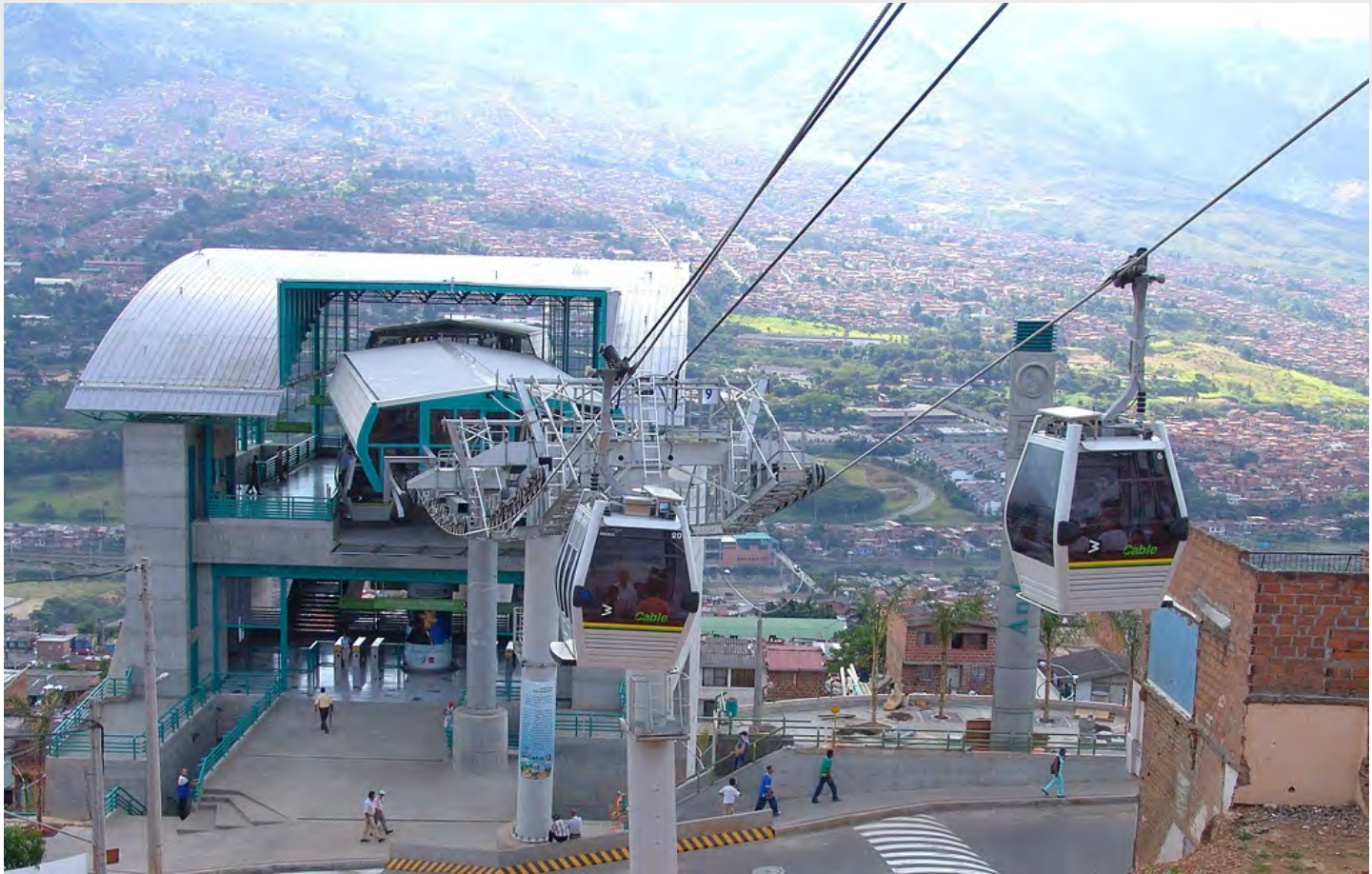
Estación Metrocable, Medellín, Colombia
