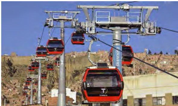
Energía Eléctrica, Paneles Solares
